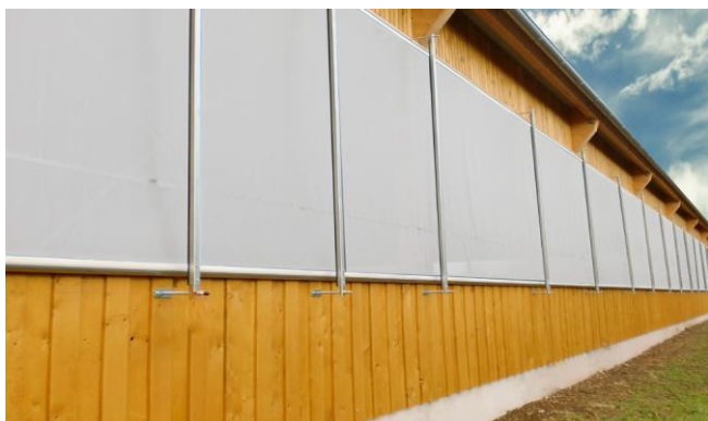
Sistem 1: Prezračevanje s spodnje strani, dvizni sistem.
