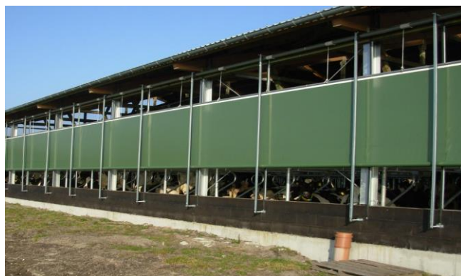
Sistem 4: Prezračevanje od zgoraj in od spodaj, nastavljen po višini za senčenje.
