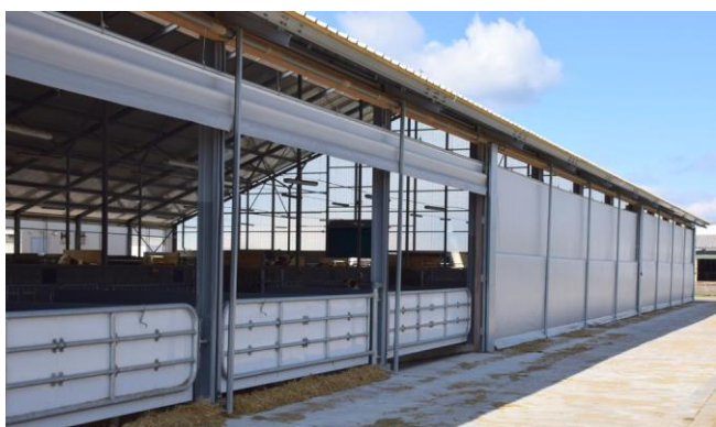
Sistem 5: Prezračevanje od zgoraj in od spodaj, nastavljen po višini za senčenje. Povečana odpornost na veter.
