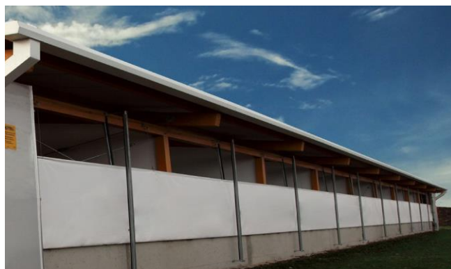
Sistem 2: Prezračevanje od zgoraj navzdol, zlaganje platna pri tleh.
