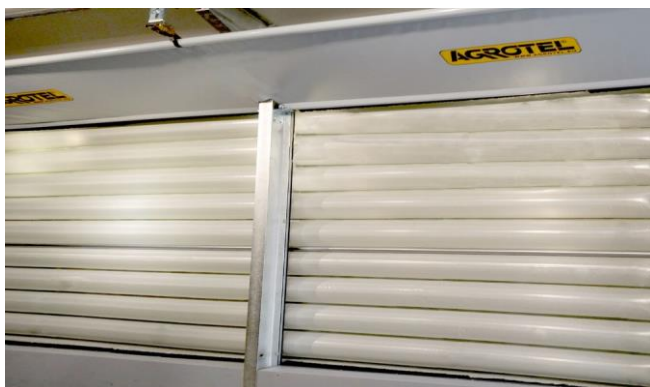
Sistem 3: Izolativni izvedba platna za prezračevanje od zgoraj navzdol.
